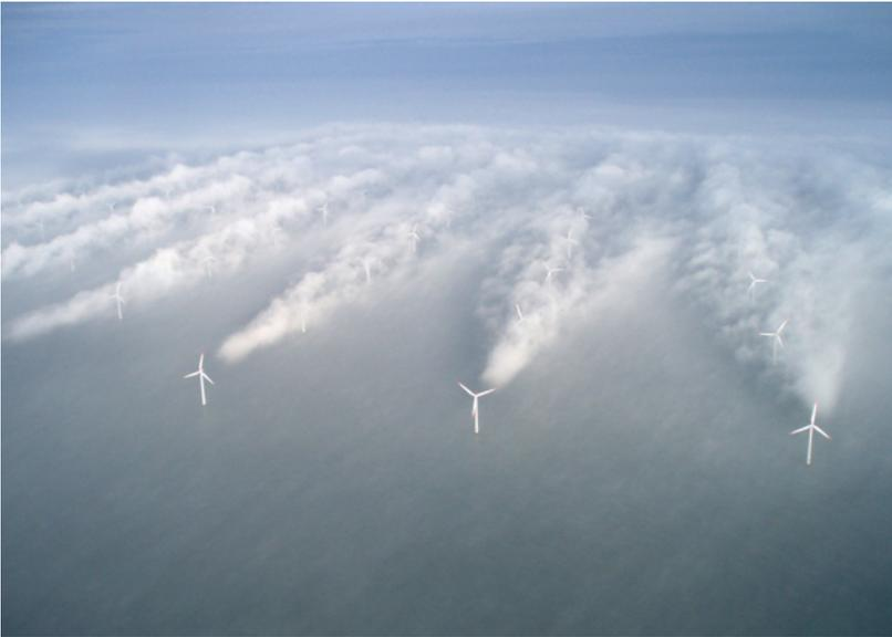
4. Parc éolien *offshore*, où les conditions météorologiques locales ont conduit à une condensation révélant une partie du sillage des éoliennes.
